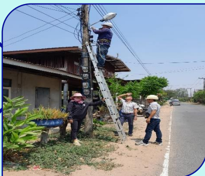
ซ่อมไฟฟ้าแสง สว่าง ม.24
