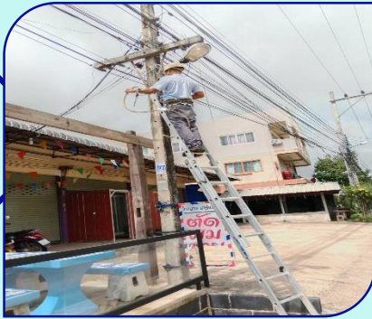
ซ่อมไฟฟ้า ม.2
